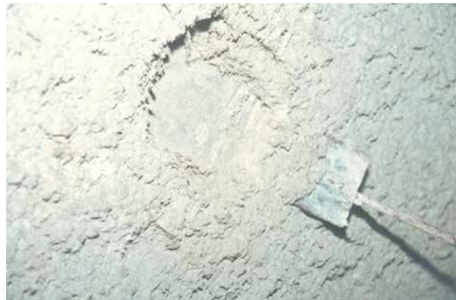
Odstranjevanje azbestne zmesi v Salonitu v času intenzivne proizvodnje
