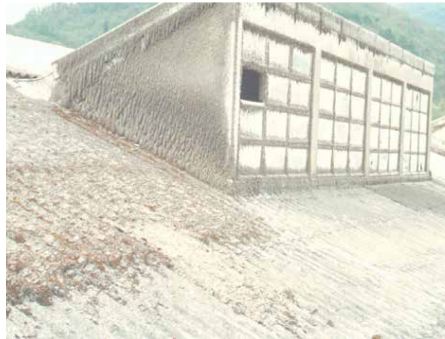
Azbest na strehi na strehi dekantatorja v Salonitu
