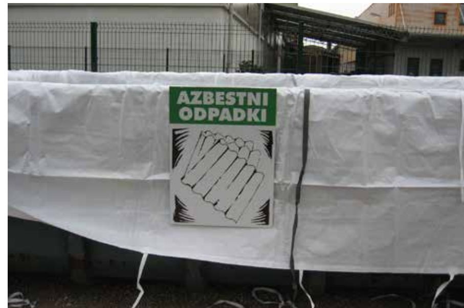
Komunalni kontejner za odlaganje azbestnih odpadkov
